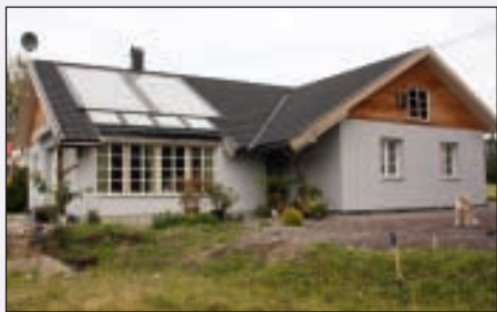
Solfangerne på dette hustaket gir 7000 kWh pr år. De produserer energi fem ganger mer effektivt enn solcellepaneler (Foto: Norsk Solfangerproduksjon)
