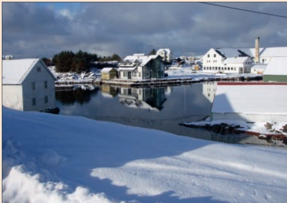
I 2008 er drømmen om varmepumper er gått i oppfyllelse. Dette moderne bygget i gammel stil ved havna i Fedje (midt i bildet) er tegnet og bygget av ingeniørfirmaet Aarland AS i Bergen. Her har man installert en sjøvannsvarmepumpe fra Alfa-Innotec og sparer derved både miljø og penger. (Foto: Hans Hagnar Aarland.)
