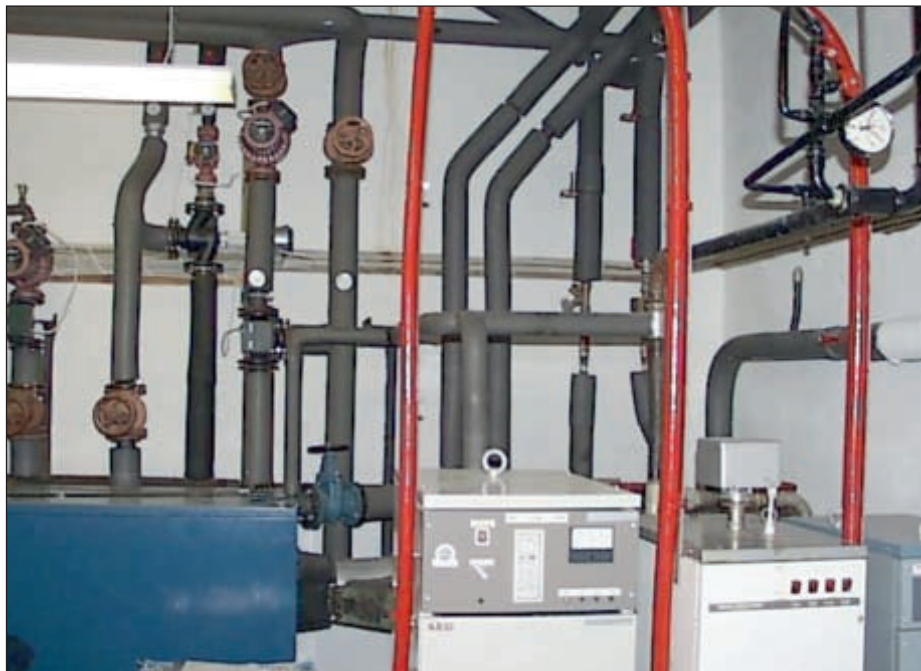
Bildet viser et konvensjonelt varmeanlegg. Det nye er at varmen tilføres en fordelingsentral i hver leilighet hvor varmt forbruksvann produseres via en varmeveksler. I perioder uten tapping benyttes varmen til oppvarming av radiator/gulvvarme samt ettervarmebatteri for ventilasjonen.
