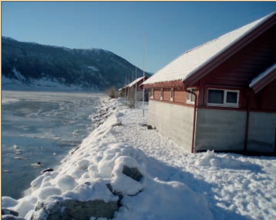
Nok varme i sjøen også vintertid og "gratis" kjøling både vår og sommer.
