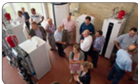
Energi og miljølaboratoriet har 12 forskellige energisystemer og for første gang har man mulighed for at skrue op og ned for systemerne og så se, hvordan det påvirker anlæggets eget forbrug og miljøet.
