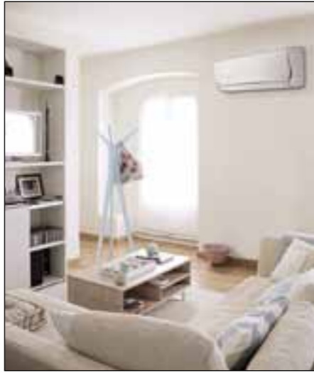
For luft/luft varmepumper bør innedelen plasseres i nærheten av der man oppholder seg mest. Det er en stor fordel om boligen har en åpen planløsning hvis man kun har en innedel.
