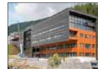
Høyskolebygget på Fosshaugane Campus i Sogndal har varmepumpe med sjøvann.
