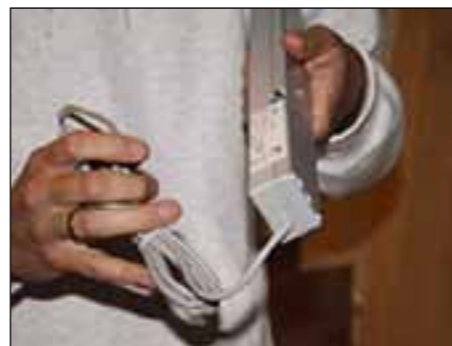
En av motorene som blir montert over vinduene.
