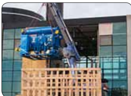
AEA - Averhoff Energi Anlæg A/S installerer tre nye absorptionsvarmepumper på Skagen Varmeværk.
