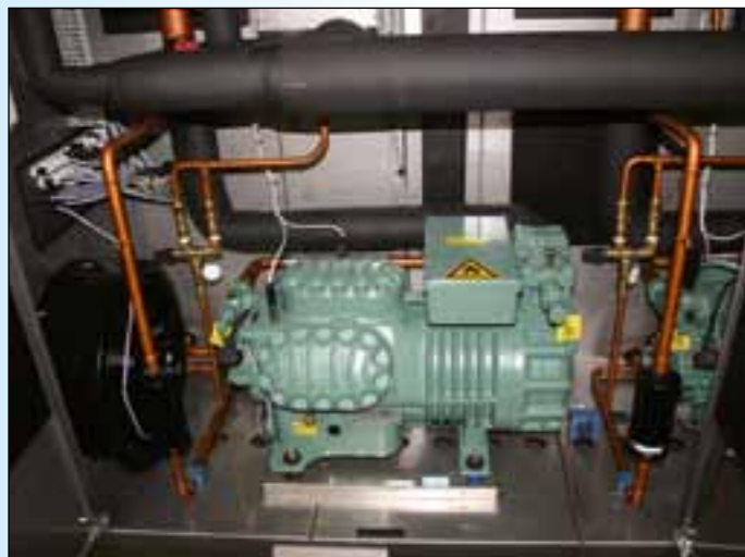
Det ble også vist frem innebygde aggregater for hydrokarbon R-1270. På grunn av eksplosjonsfaren har utvikling på dette området gått relativt tregt. På bildet ser man den blå føleren som starter opp viften nederst til venstre og to viften på toppen om gasskonsentrasjonen blir for høy.
