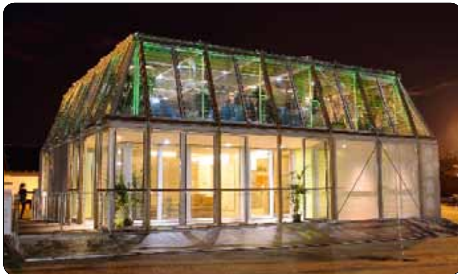
Grundet de små pladskrav kan anlægget både benyttes i lejligheder og alle former for enfamiliehuse. Her ses vinderhuset.
