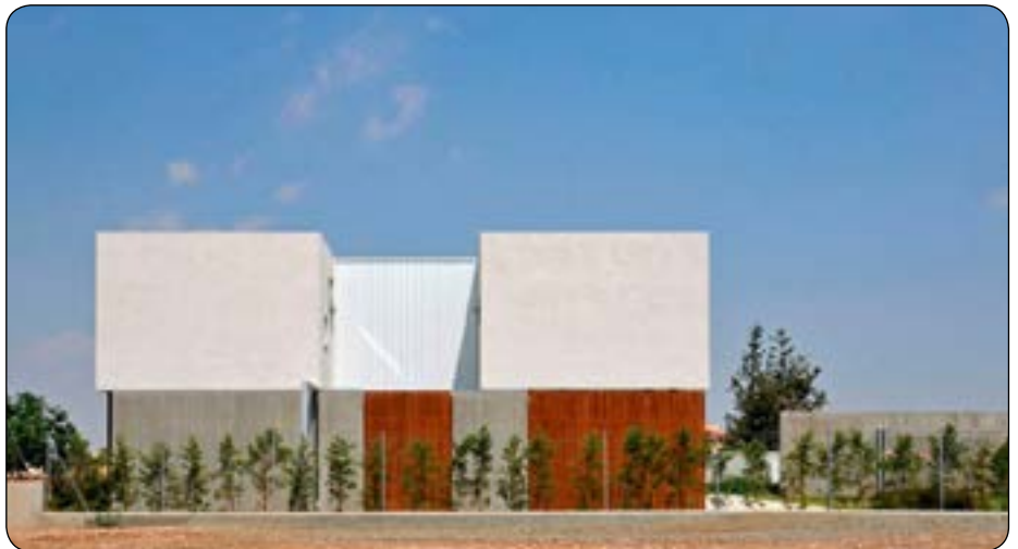
Hvide tage kan give betydelige energibesparelser på kølehuse, frysehuse og kan være fordelagtig i bygninger med høj intern varmebelastning.
