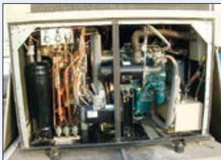
Sanyo gass varmepumpe.
