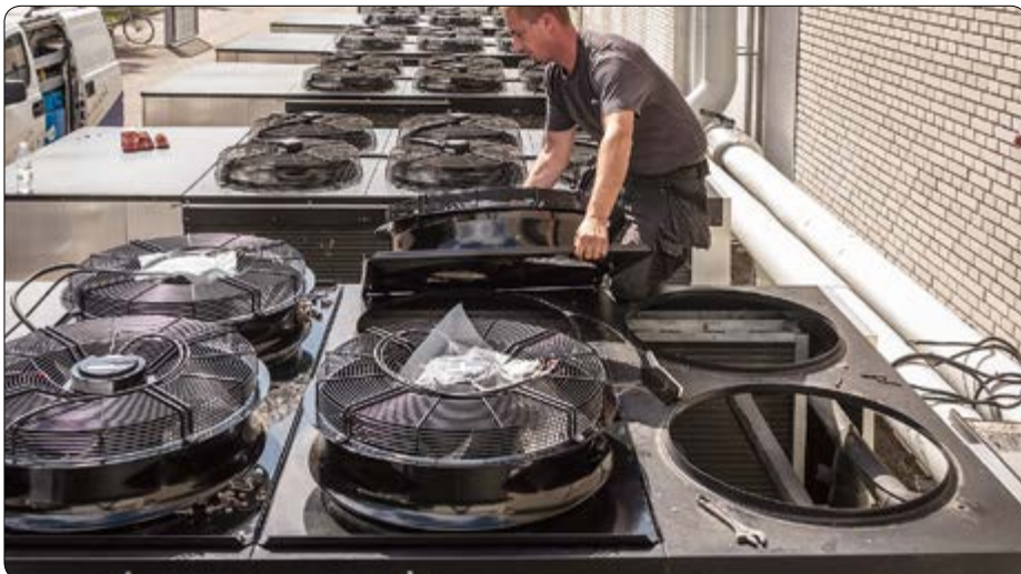
EC-ventilatorerne fra ebmpapst har samme dimensioner som de fleste standard ventilatorer. Derfor er udskiftningen hurtig og enkel: 4 skruer af og 4 skruer på.
