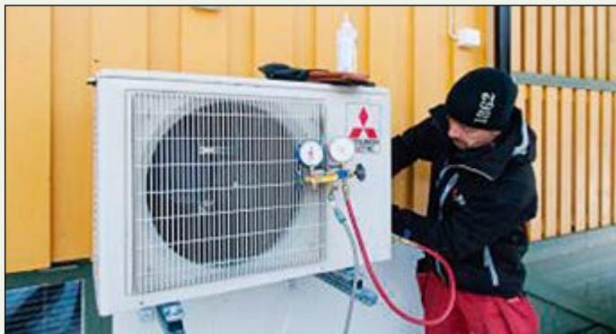
Ved plassering av utedelen bør du tenke på om støy fra varmepumpen sjenerer naboene (Miba AS).
