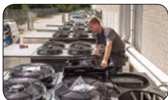
86 Sparede 34 % med EC ventilator
