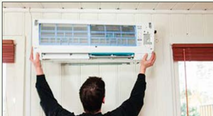
Varmepumpens innedel bør plasseres i nærheten av oppholdssonen for å sikre effektiv luftfordeling i boligen. (Miba AS).
