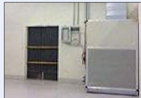
Gassdrevne varmepumper kan oppnå en energipris på 0,25 kr/kWh, ifølge GHP-Norge.
