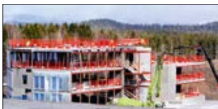
Satsing på prøvd ventilasjonsteknologi ga Enova-støtte til R8 Property.
