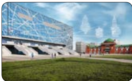
Danfoss holdt isen kold og tilskuerne varme under ishockey VM i VTB Ice Palace bygningen i Moskva. Foto: Danfoss
