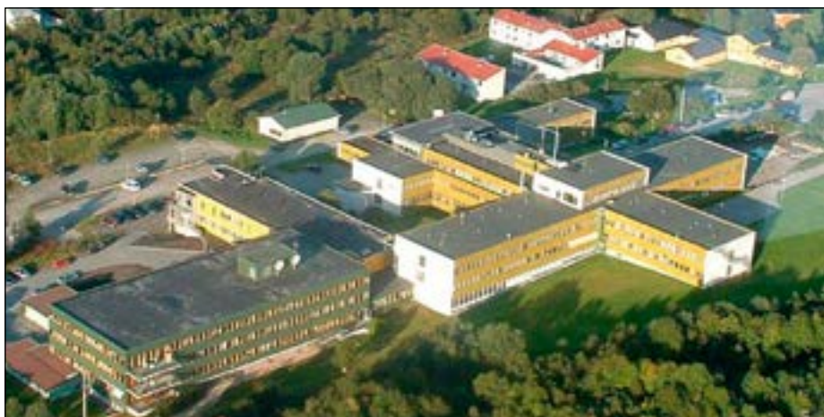
Det skal installere 3 stk parallellstilte varmepumper, med en samlet levert effekt på 240 kW med en maks. turvannstemperatur på 65 °C.
