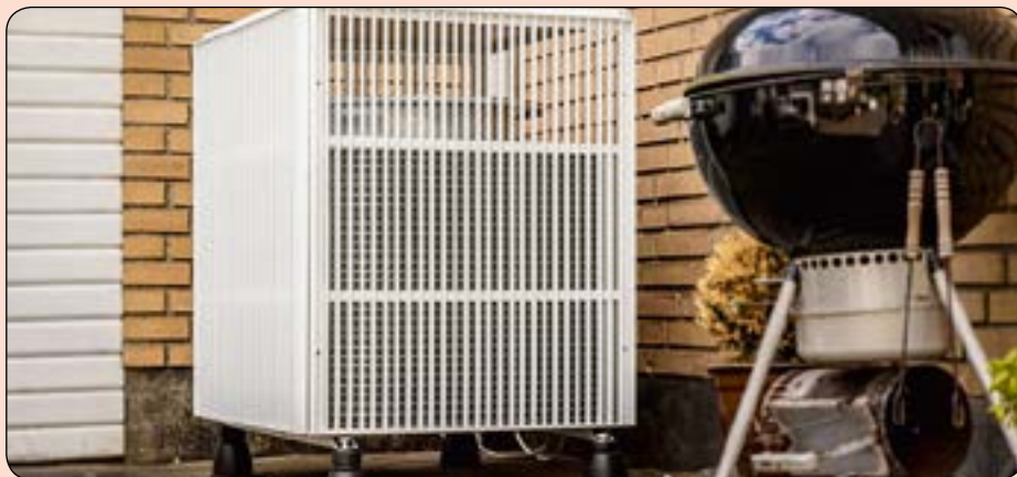
Udedelen af Suntherms varmeanlæg udgøres af en luft-vand varmepumpe, der er designet sådan, at lydniveauet ifølge direktøren er meget lavt. Foto: Suntherm
