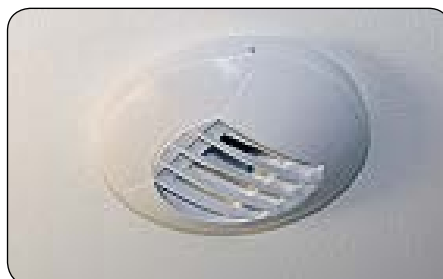
Neotherm ventilen på badeværelset åbner og lukker for ventilationen efter behov.
