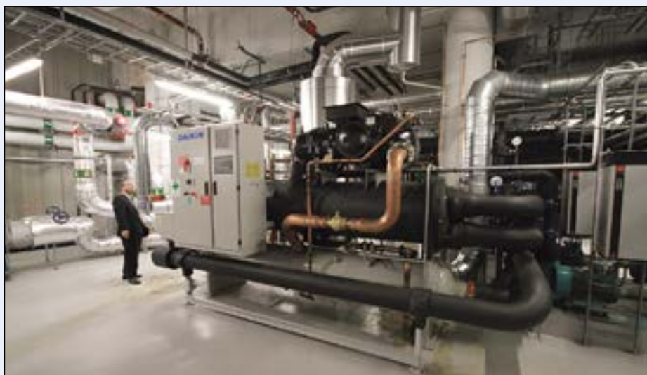
Basert på Eurovent leverer VZ en årskjølefaktor på hele 8,7. Den imponerende energieffektiviteten på Daikin VZ skyldes i stor grad Daikin sin egenutviklede og optimaliserte inverter skruekompressor. Denne tillater kapasitetsreduksjon helt ned til 20 % kun ved bruk av inverteren.
