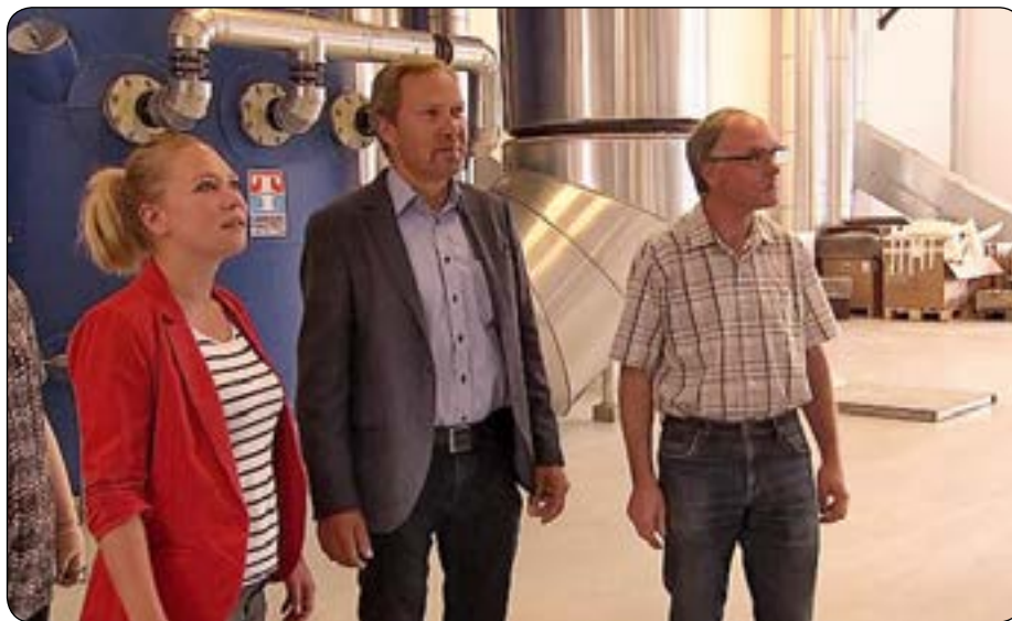
Lisbeth Bech Poulsen blev vist rundt på varmeværket sammen med formanden, Per Horup (i midten).
