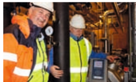
Prosjektleder i Forsvarsbygg Arne Alvik (t.v.) og teknisk byggeleder i Forsvarsbygg Rune Teigland foran varmepumpens kontrolldisplay. Foto Åsmund V. Sjørusen, Forsvarsbygg.
