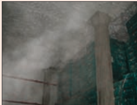
Is og frostrøyk i fryselageret før man fikk avfukter.
