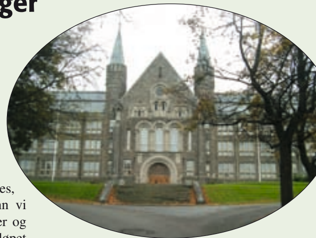
Hovedbygget på NTNU i Trondheim.
