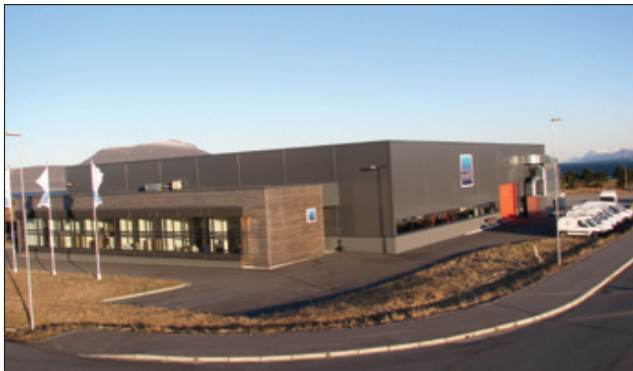
MMC KULDE satsar friskt og flyttet i november inn i sitt nye hus på 2.000 kvadratmeter i næringsparken, i gangavstand frå Ålesund flyplassen.
