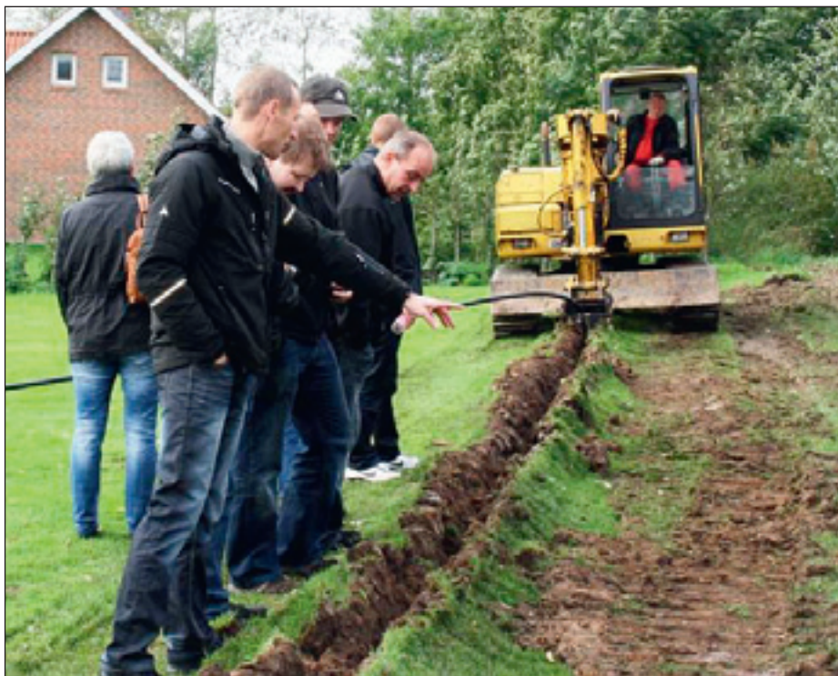
Pløjeteknikken er både hurtig og effektiv. Det kunne de besøgende overbevise sig om, da Thybo Køleteknik sammen med IVT Naturvarme forleden inviterede til nedpløjningsdemo i Gundstrup ved Alssund Golfklub.
