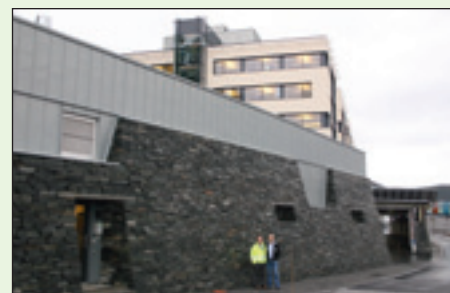
For unngå støy er driftssentralen, som ligger midt i et kontorområde, bygget inn i en skråning og med steinmur i fasaden og sluser i porten inn. Det er også benyttet støydempede kondensatorer på taket.
