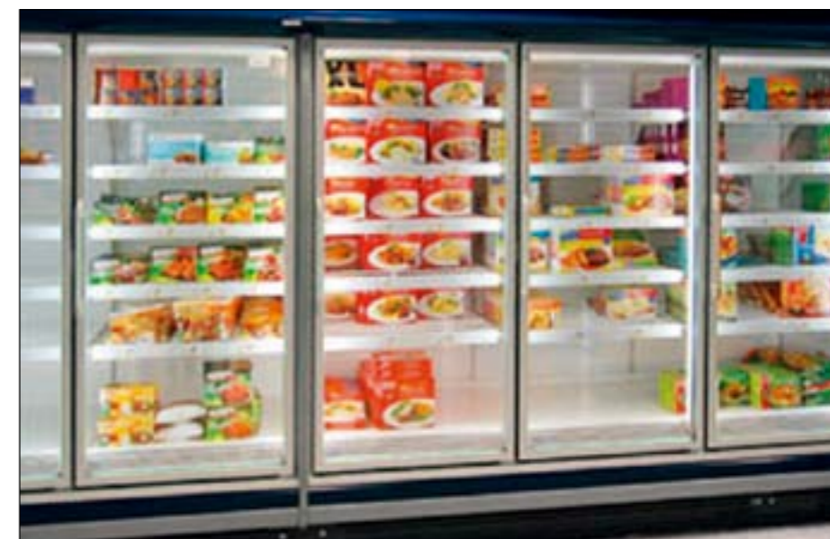
Elvärme i karmar till kylmöbler kan ta bort huvuddelen av vinsten med lägre drivenergi. Om karmvärme ändå installeras, så förse den med manuell avstängning och prova utan.
