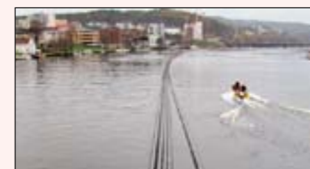
Rørene på vei opp elven Otra. Disse rørene vil snart befinne seg på bunnen av Otra og utvide frikjøleanlegget fra Kjøita til Sørlandet Sykehus. (Foto: Agder Energi)
