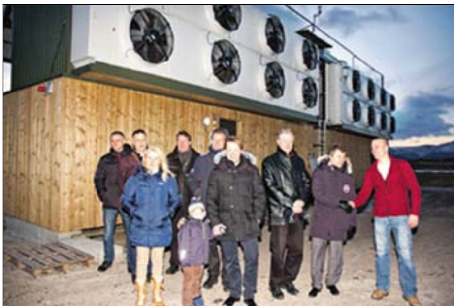
Verdens største luft-vann varmepumpe er nå i full drift ved Andøya flystasjon. Fra høyre gratulerer Kjetil Finne (prosjektleder i Norsk Kulde), Jens Hugo Leiknes (prosjektleder Forsvarsbygg). Videre står Gunnar Solbjørg (programansvarlig for energiledelse i Forsvarets bygningsmasse), Stig Robertsen (underleverandør VVS installasjon) med sønnen Magnus, og representant for 133 luftving, Beate Stellander. Bak fra venstre Bjørn Ivar Kampen, (prosjektleder energiprojekt), Ragnar Madsen, fagingeniør Forsvarsbygg (tilholdssted Andøya flystasjon), Arild Blom Svenning, (energiansvarlig Forsvarsbygg) og Kjell Hantho, ekstern rådgiver på energiledelse. (Foto: Mette-H. Berger Amundsen)
