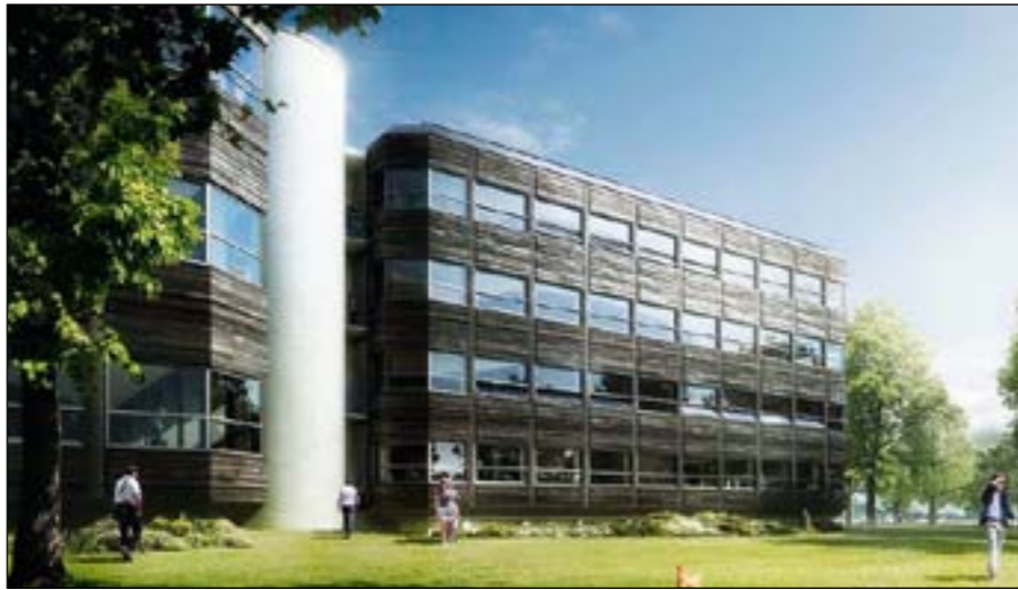
Ved å optimalisere og kombinere kjent teknologi på nye måter, kan et ordinært kontorbygg fra 1980-tallet på Kjørbo i Sandvika produsere mer energi enn det bruker.
