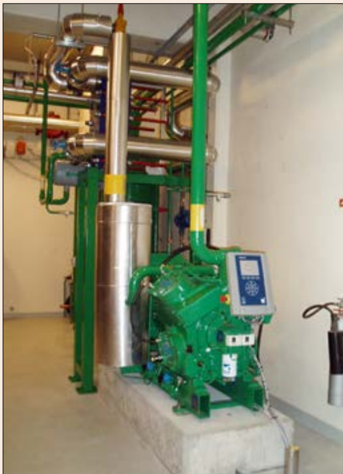
Figur 1: Eksempel på 40 bars ammoniakk varmpumpe for leveranse av varme på ca. 65-68° C.
