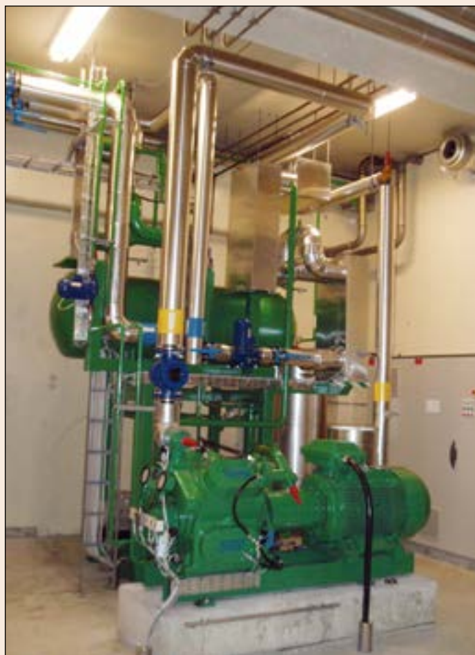
Figur 2: Eksempel på hybridvarmpumpe for leveranse av varme på ca. 80-95° C stempelkompressor.
