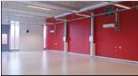
Panasonics 3-rørs varmepumpeanlegg i Avencias lokaler på Bjørkelangen er det første i sitt slag i Norden.
