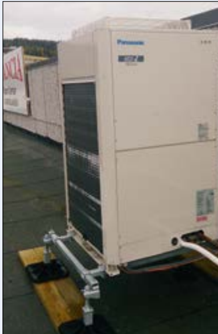
Utedelen tilbyr maksimal brukseffekt i Avencias lokaler, der overskuddsvarme hentes i et rom som kjøles ned og brukes til oppvarming i et annet rom i samme lokale.
