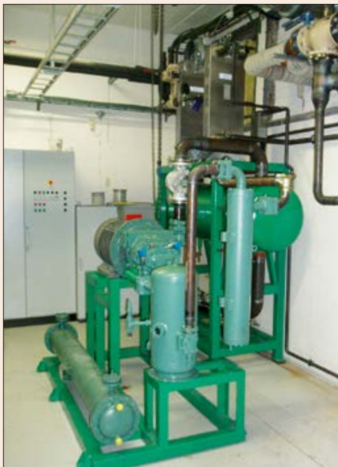
Figur 3: Hybridvarmpumpe med skruekompressor til bygningsoppvarming.
