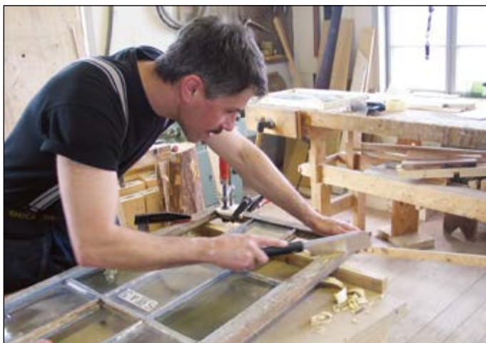
Gammelt er godt: Restaureringsekspert på Antikvarisk verksted i Røros, Olaf Piekarski spunser et vindu til Røros kirke. Vinduene i kirken er 250 år gamle.
