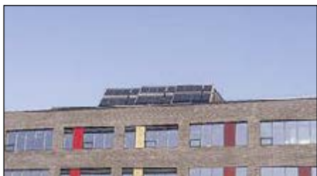
Når elevene skur på det varme vannet i skolens undervisningskjøkken, er det varmet gjennom 100 kvadratmeter solfangerne på skolens tak.
