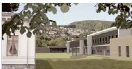
Frydenhaug skole i Drammen bruker bare 37 kWh/m 2 pr år! Dette er muliggjort ved bruk av solfangere og varmepumpe i et optimalt samspill i kombinasjon med en bygningskropp.
