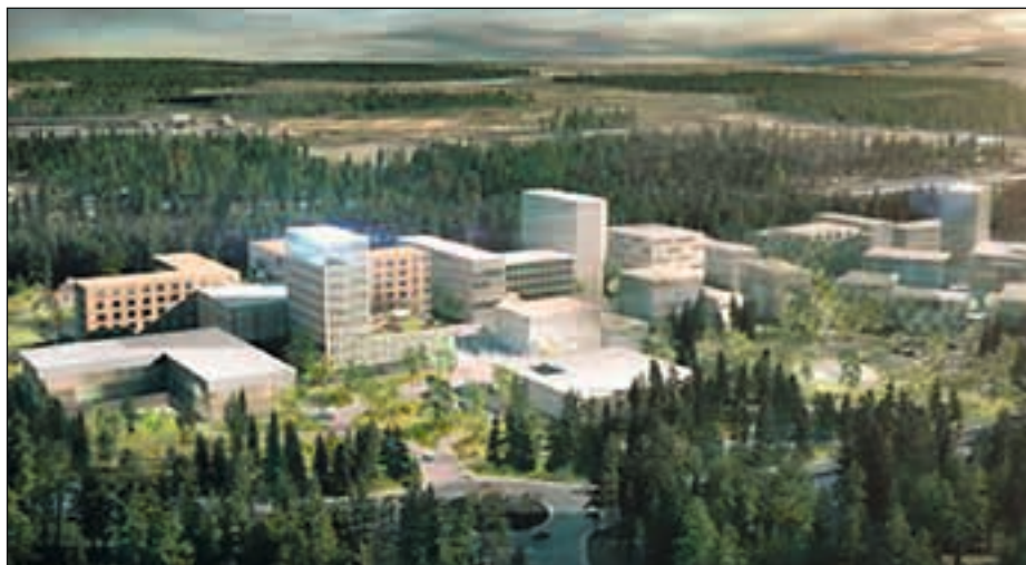
Oslofjord Varmer nå igjen i gang med en Energisentral basert på geotermi for det nye sykehuset til Landsforeningen for lungesyke. Norsk Energi er engasjert som rådgiver i prosjektet.
