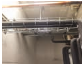
14 Installasjon og rørmontasje av CO 2 -kuldeanlegg
