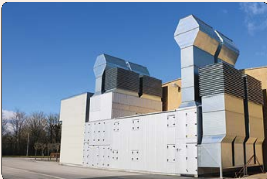
CO 2 -fri køleløsning er ét af resultaterne af samarbejdet mellem NB Ventilation og Munters. Behageligt opholdsklima og minimalt vedligehold er et par af de andre resultater, som Danfoss A/S oplever med de nye anlæg.
