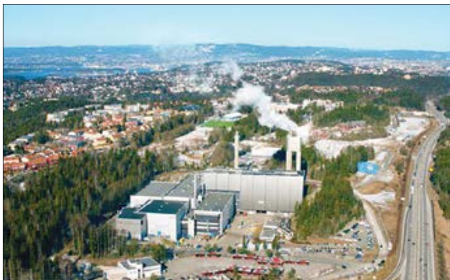
Fortum Oslo Varmes soppelforbrenningsanlegg på Klemetsrud i Oslo.
