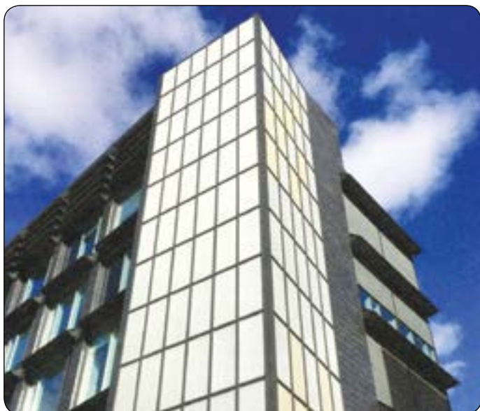
Figur 2. Solvæg på Kalkværksvej 10A, Aarhus Kommune.
